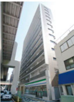
パークキューブ新板橋
